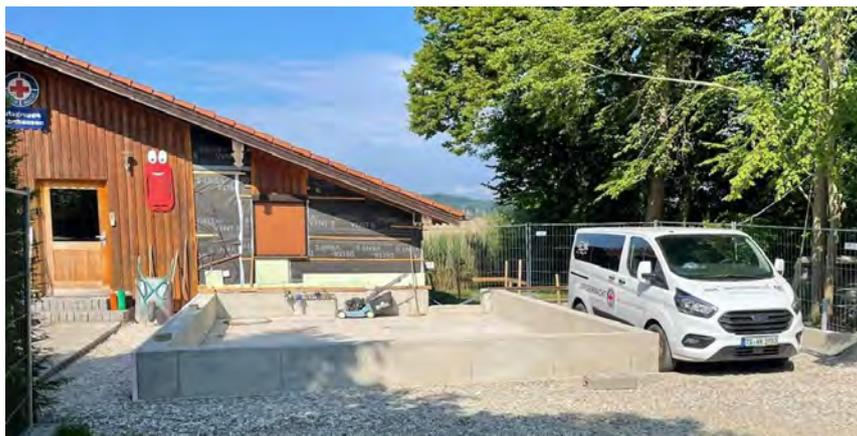
rückwärts bis zur Baustelle fahren müssen. Das Wetter spielte immer noch nicht mit und so stand am darauffolgenden Tag, das Regenwasser ca. 5 cm hoch auf der Betonplatte. Im Anschluss wurde die Aufkantung eingeschalt und bewährt um diese eine Woche später mit 7m<sup>3</sup> Beton fertig zu stellen. Im nächsten Schritt wurde das Fundament für die Garage des Einsatzfahrzeuges betoniert und zwei Reihen Schalungssteine daraufgesetzt, verfüllt und
